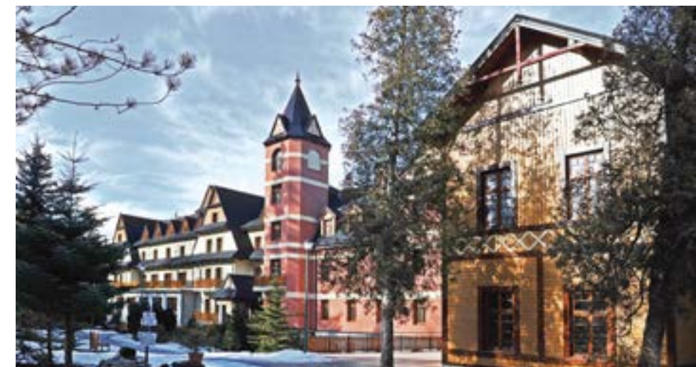
Centrum Formacyjno-Szkoleniowe Księżówka w Zakopanem, gdzie pracują kotły firematic
